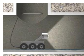
管路検査ソリューション
